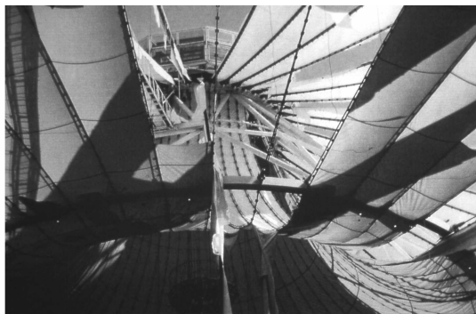
图 1 日本熊本公园穹顶在风荷载下的破坏情况
