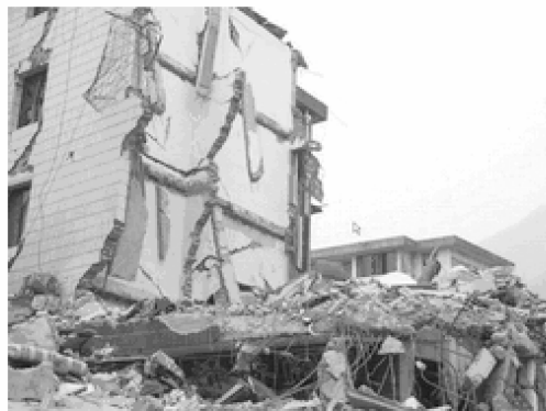
(b) 多层砌体结构倒塌
