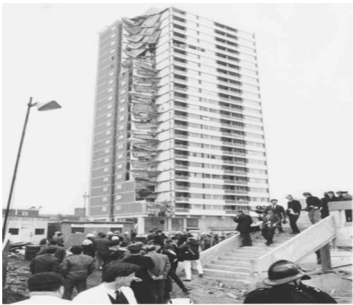
(a) 英国罗兰公寓天然气爆炸导致的破坏
