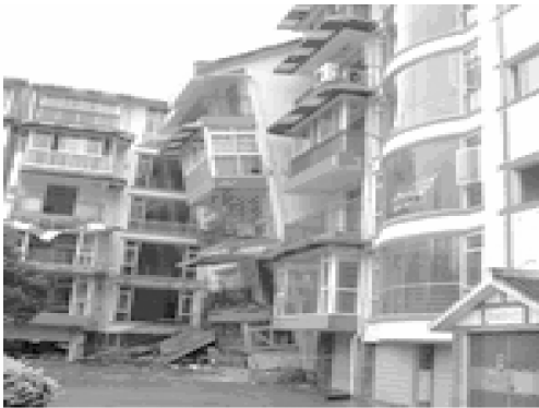
(a) 某框架结构底层坍塌
