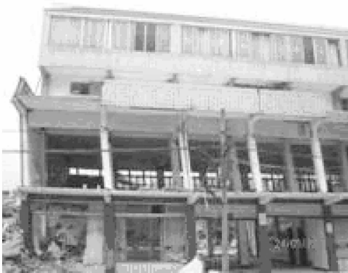
(c) 某框架柱二层铰机制破坏
