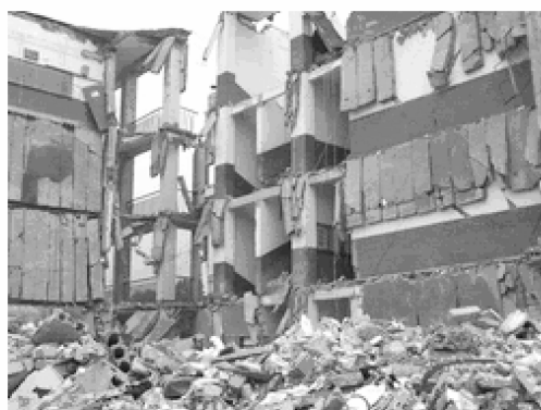
(c) 底框结构倒塌
