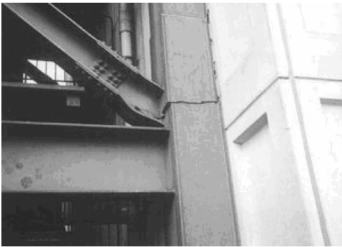
图 6 阪神地震某结构钢柱断裂
