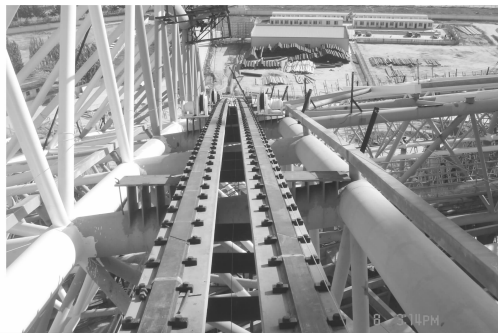
图 10 台车轨道的施工安装
