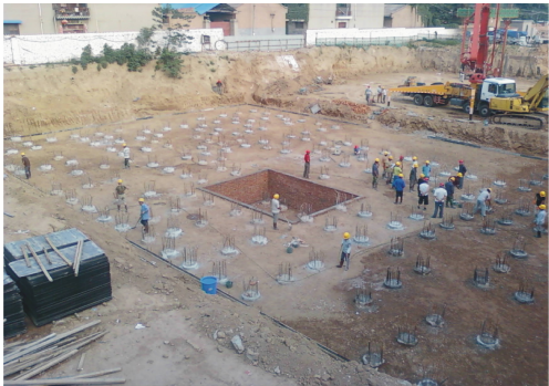
图 5 后压浆灌注桩破桩后的效果 Fig. 5 Effect of Post-grouting Bored Piles After Broken
