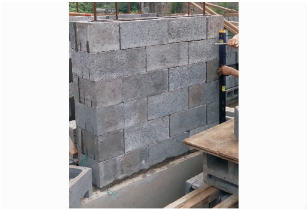
图 3 试件制作现场
