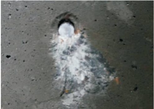
(b) 混凝土面上的断痕
