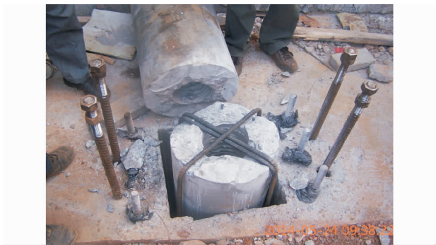
图 11 锚杆静压桩封桩
