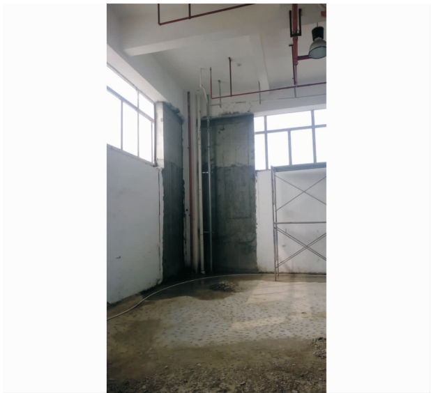
图 7 厂房角隅处增设短肢剪力墙
