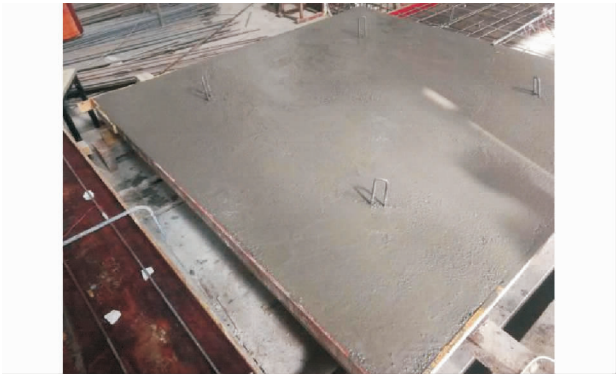
图 4 叠合板浇筑 Fig. 4 Pouring of Laminated Slab 表 1 混凝土抗压强度
