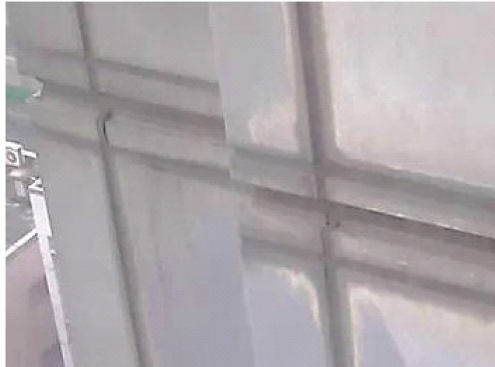
(b) 装配式外墙拼接缝
