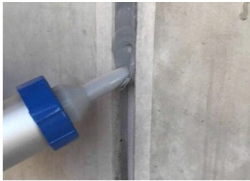
(a) 密封胶施工
