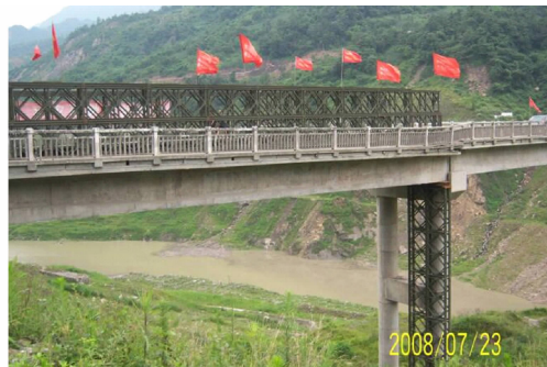
图1 寿江大桥震后应急措施
