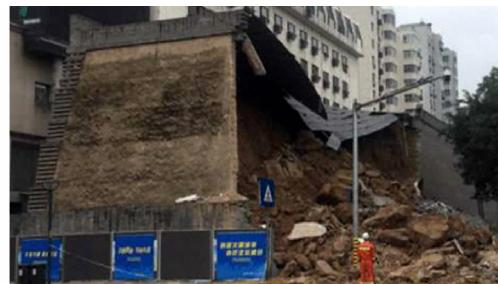
图 1 某明城墙修复段局部坍塌
