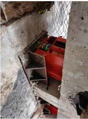
图 2 混凝土水平支撑上的轴力伺服系统 Fig. 2 Axial force servo system on concrete horizontal support
