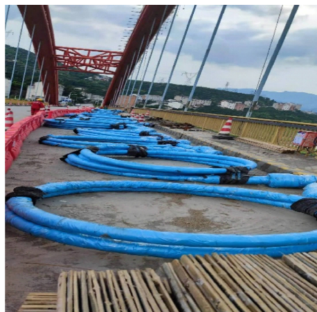
(b) 吊杆更换
