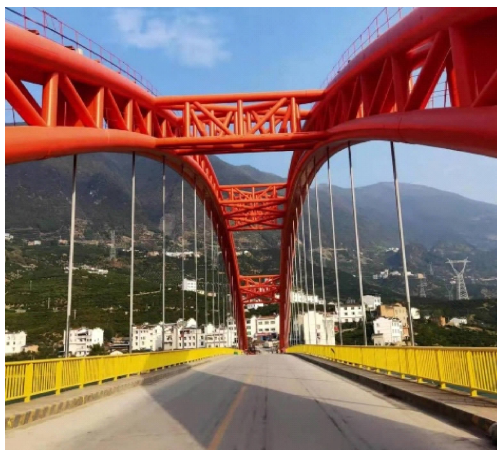
(a) 拱桥整体
