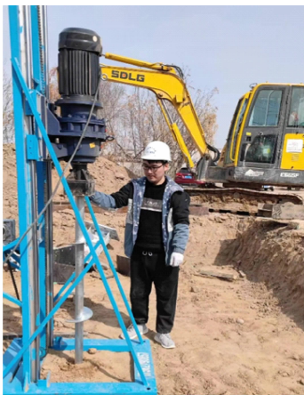
图 4 专业打桩设备
