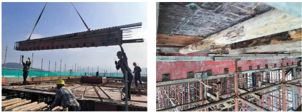
(a) 桁架钢筋笼吊装 (b) 浇筑中梁底未支撑
