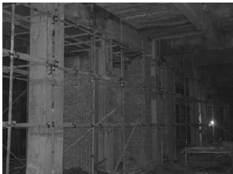
图6 柱加固后的外观
