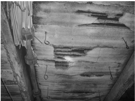
图 5 火灾后楼板破坏情况 Fig. 5 Damage Situation of Floors After Conflagration 并且裂缝不断发展,而且大多数裂缝都贯穿墙体两面,最大裂缝宽度达20 mm,裂缝走势和分布规律不明显,但水平方向裂缝很少,开始裂缝发展较快,后面裂缝发展缓慢。经专家组分析,可能是由于整个框架在火灾后受损不均匀,从而引起受力不均所造成的。墙体加固采用钢丝网-高性能修补砂浆加固法。该商业大楼经过加固处理后,裂缝不再发展。
