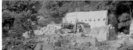
图 1 砖混结构的震害
