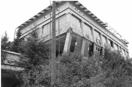
(b) 北川某框架二层柱铰破坏
