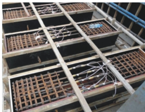
(a) 混凝土浇筑前
