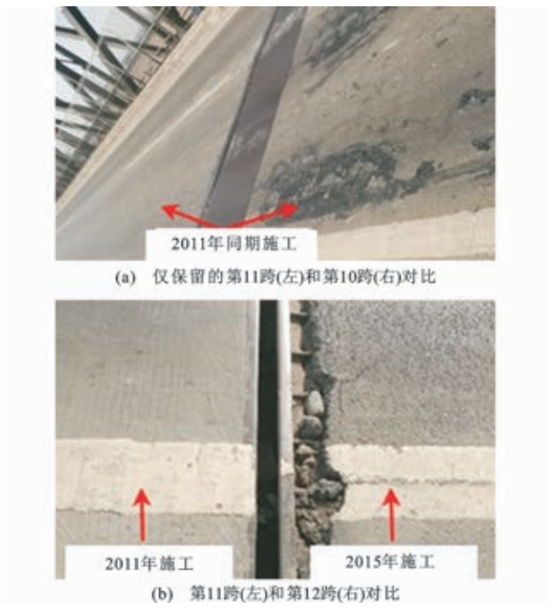
图 23 轻型组合桥面(第 11 跨)与相邻跨环氧沥青方案对比
