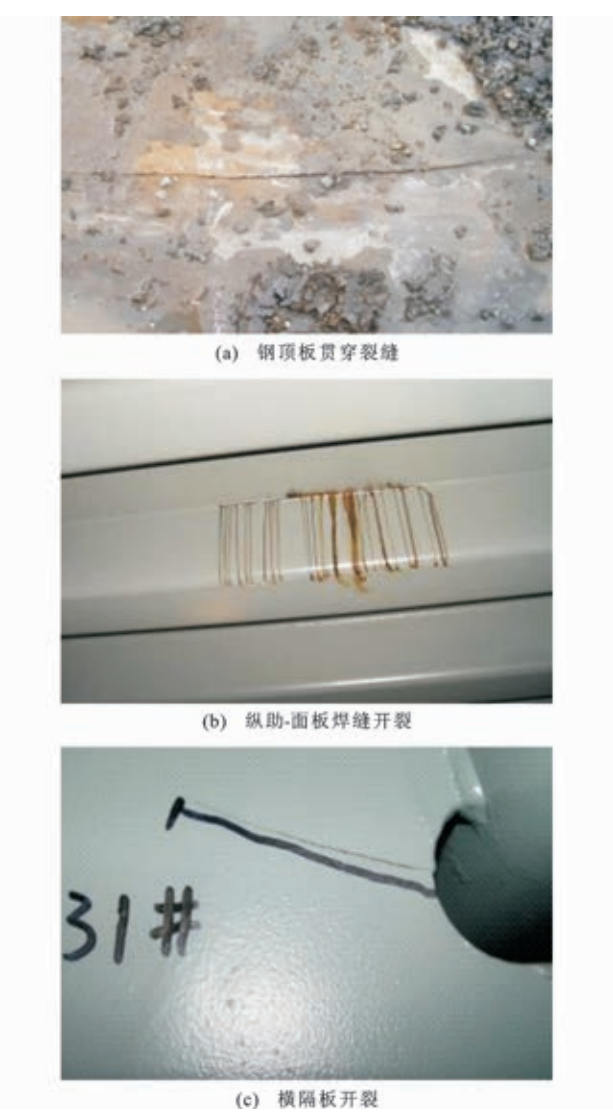
图 16 正交异性钢桥面疲劳开裂病害 Fig. 16 Fatigue Cracking Diseases of Orthotropic Steel Deck 引发上述病害的主要原因为:①由于局部刚度
