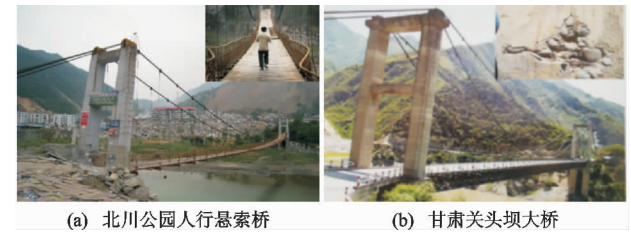
图 3 汶川地震中悬索桥震害
