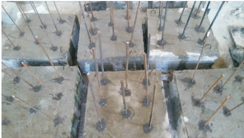
图 1 水平面植筋 Fig.1 Planting Rebars in Horizontal Plane
