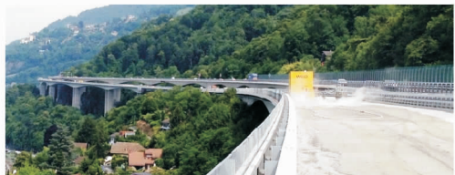
(b) Chillon高架桥UHPC加固(Eugen Brühwiler提供)
