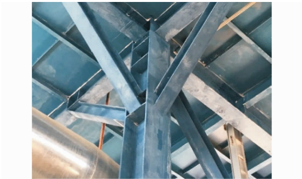
图 3 钢框架梁柱节点
