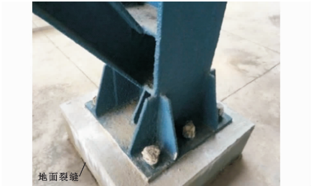
图 4 柱脚刚性节点
