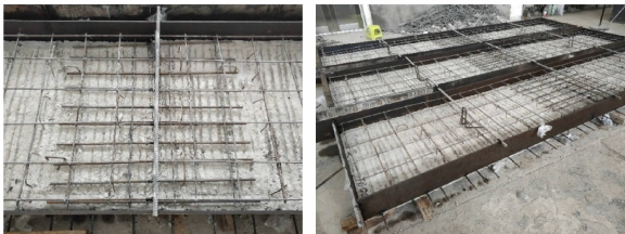
(b) 现场施工图1 (c) 现场施工图2
