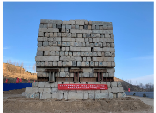
图 4 试桩静载试验 Fig. 4 Static load test of test pile
