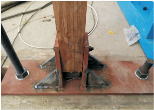
(b) 柱脚与地梁的连接
