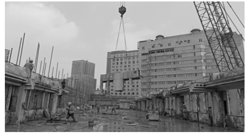
图 8 切割吊装施工
