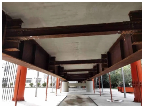
图1 曲线双工字钢板组合梁桥
