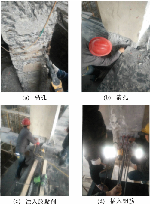
图 2 植筋技术施工流程
