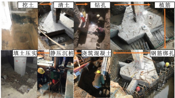
图 5 承台施工流程
