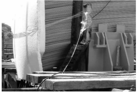
图 3 保温层的安装
