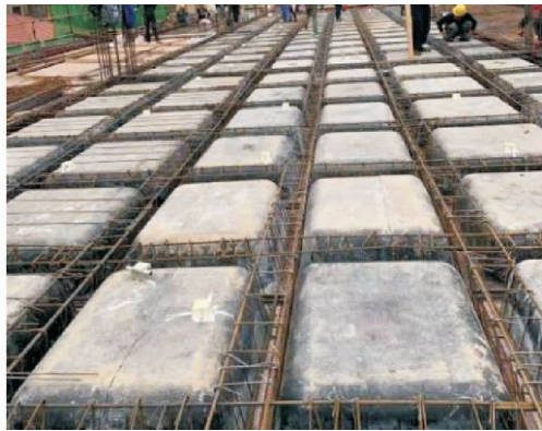
图 1 空腔楼板结构 Fig. 1 Hollow-floor Structure
